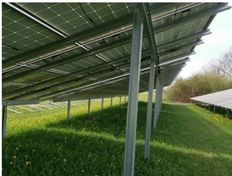
Figura 10 Tipico strutture di sostegno
